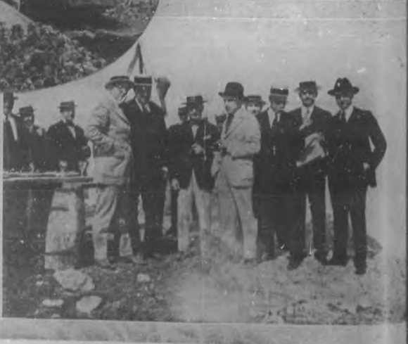
Varios aspectos del acto de la colocación de la primera piedra del frontón de mujeres, celebrado recientemente.
