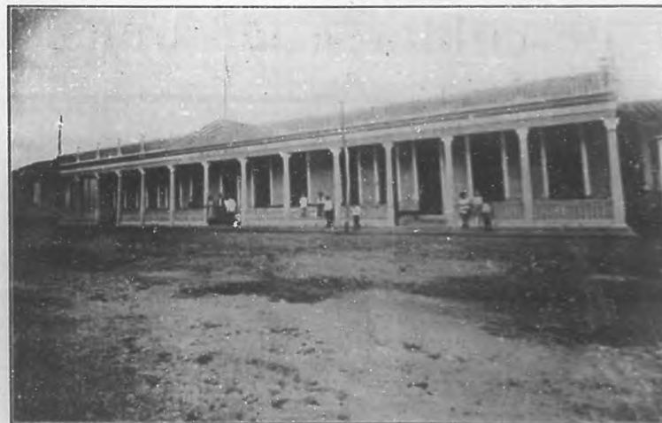
DE SAN LUIS, (Pinar del Río).—El nuevo edificio escolar.
